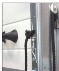
Rys. 1 Otwieranie ręczne (ciągnio sznurowe)
